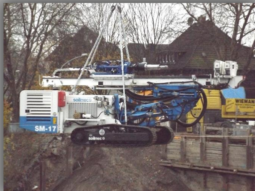
Einheben in die Baustelle.
